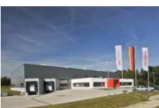
Das Gebäudekonzept für den Neubau der Cellpack GmbH in Radeberg wurde im Workshop entwickelt und berücksichtigt effiziente Kommunikations- und Produktionsabläufe und Erweiterungsmöglichkeiten.
